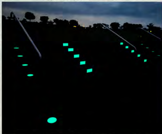
階段に取り付けた蓄光タイル ＝小松市の木場潟公園中央園地（小松中央L C提供）
